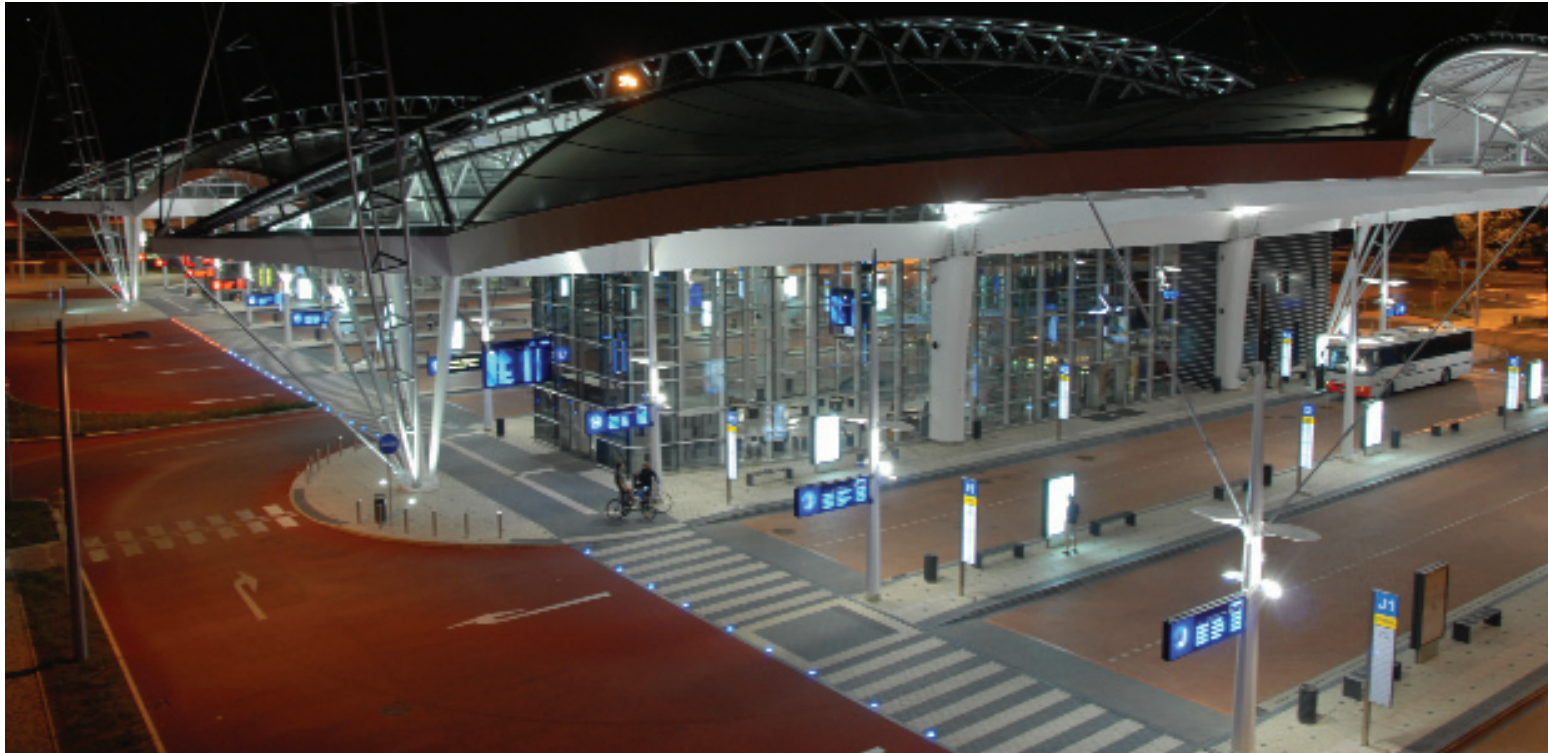
Autobusový terminál v Hradci Králové, terminál I (Etapa I)
