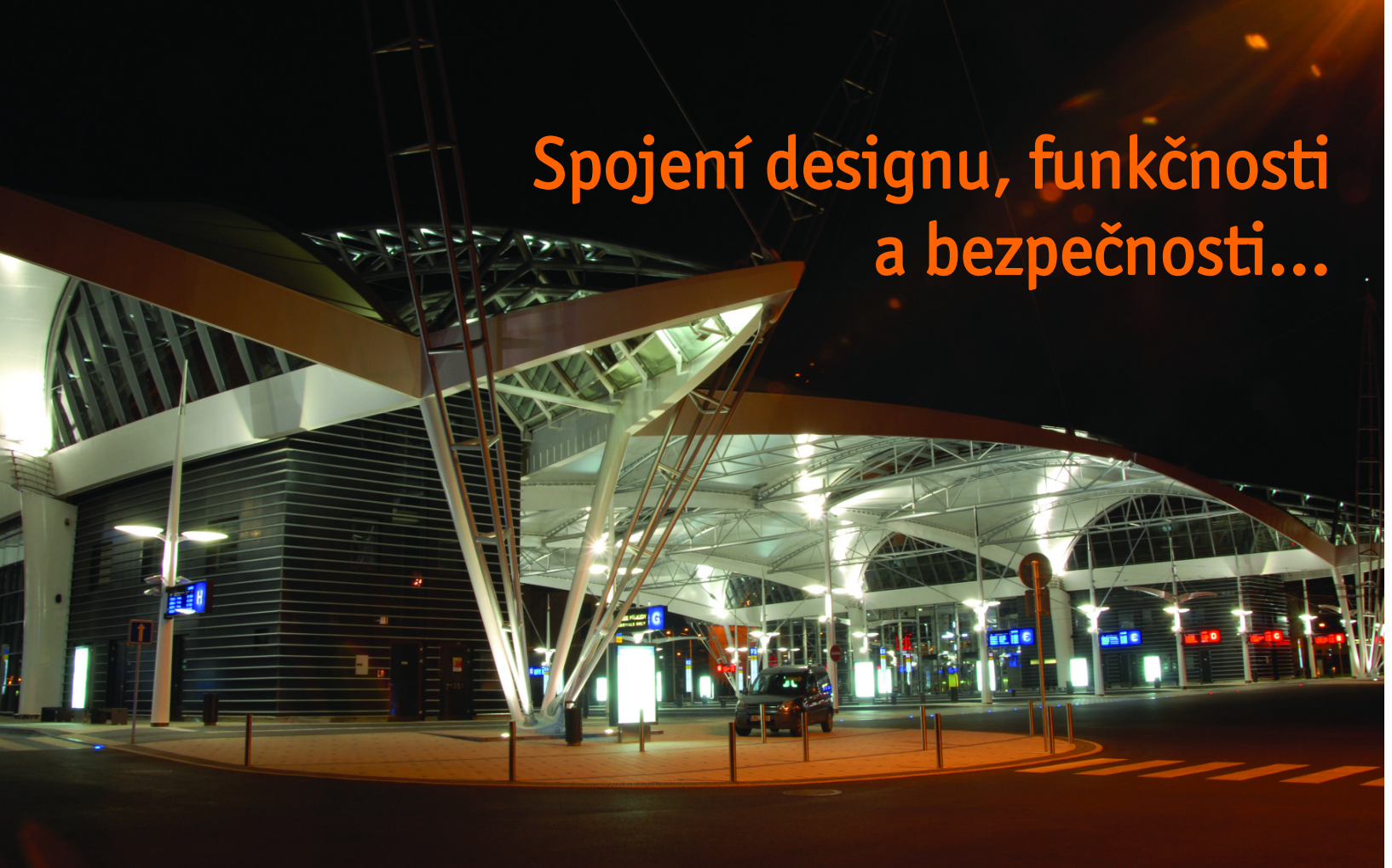
Autobusový terminál v Hradci Králové, terminál I (Etapa I)
